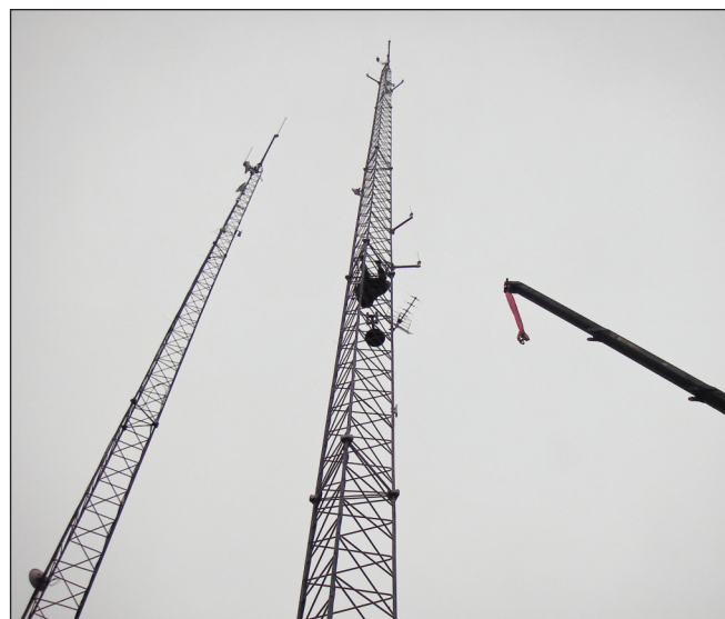
Brian Kjær på vej op i den nye mast for at lave de sidste rettelser.
